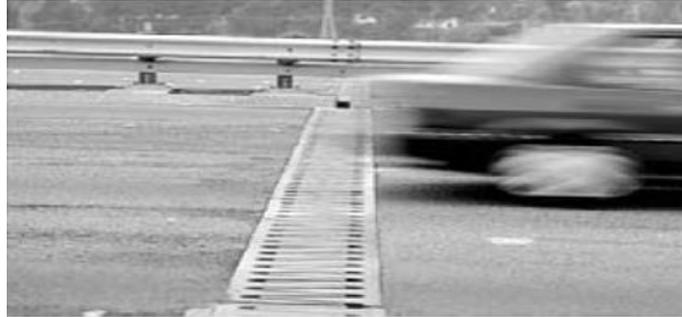
Este hueco en el asfalto de un puente se llama junta de expansión; permite que el puente se dilate y se contraiga.
